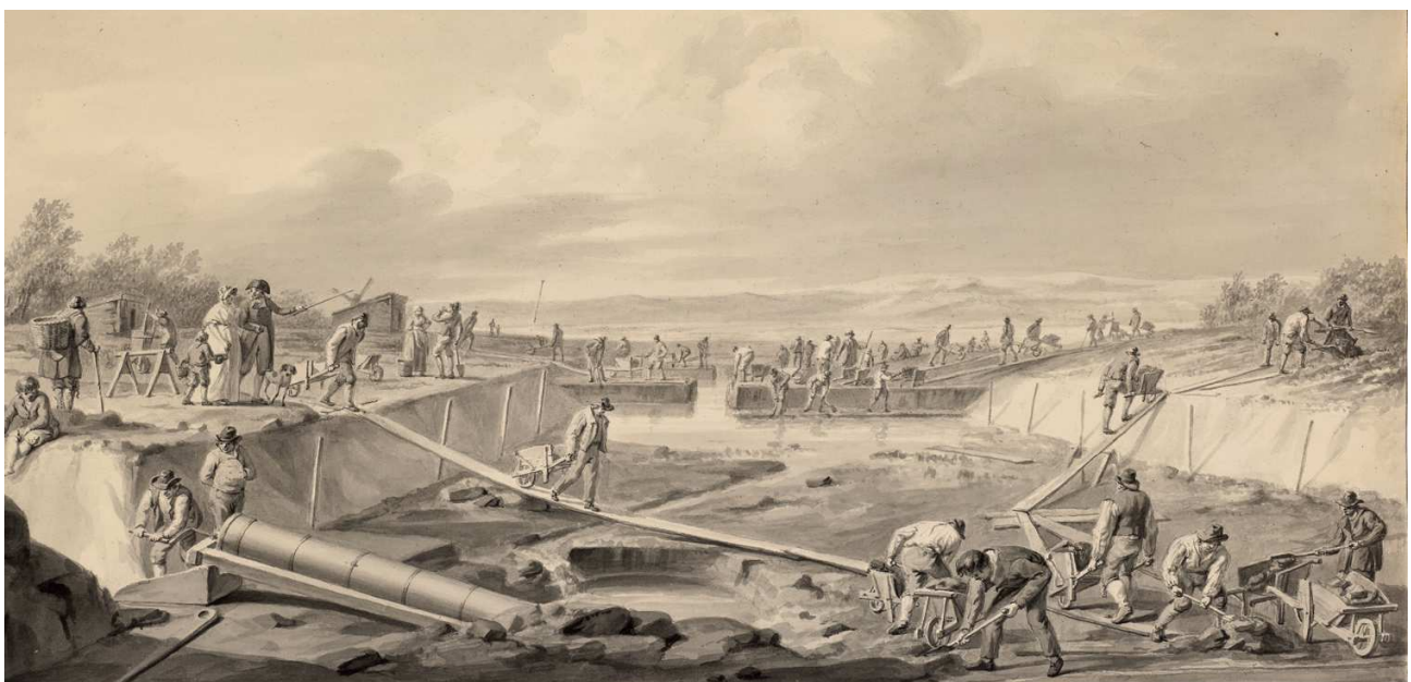
Pentekening van het graven van het Uitwateringskanaal bij Katwijk (1804-1805). 24 Bij het graven van het Kanaal van de Leede is een vergelijkbare techniek toegepast. Links op de voorgrond is een tonmolen te zien.
