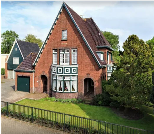
Afb. 7 Villa Rusthoff, Hoofdstraat 222.
