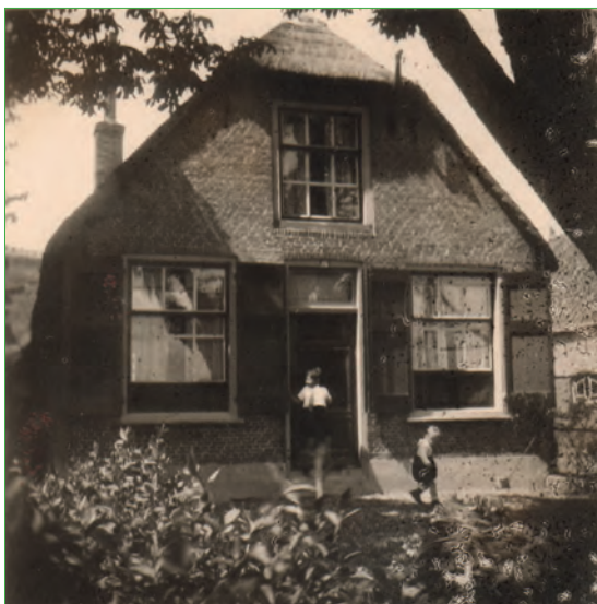
Boerderij Zegwaartsweg 46, in 1865 bewoond door veehouder Adriana Langelaan, weduwe van Leonardus Droogh. De boerderij is in 1992 afgebrand
